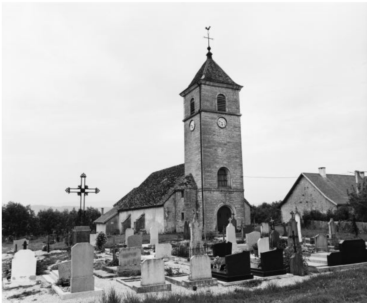
Façades antérieure et latérale gauche.
