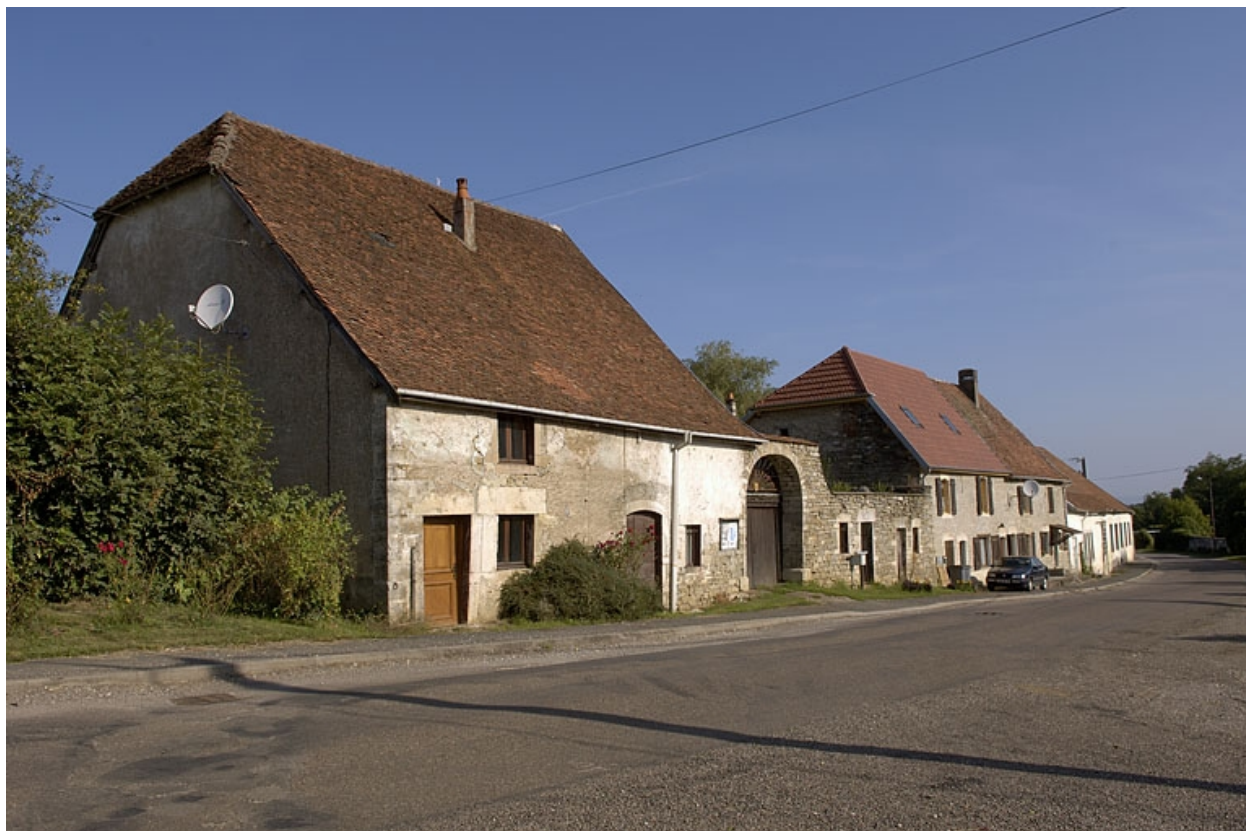
Logements ouvriers vus depuis le sud-est.
