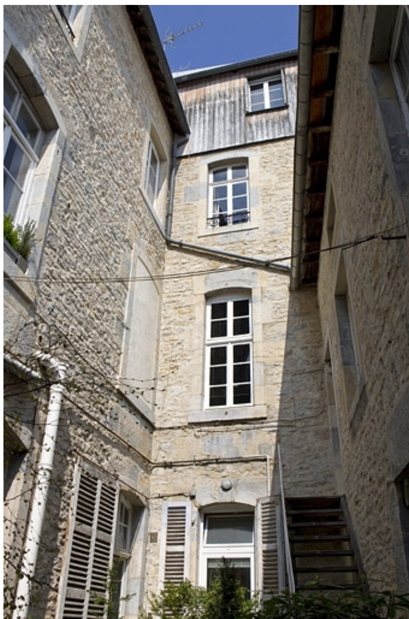
Vue des façades donnant sur l'ancienne basse-cour.
