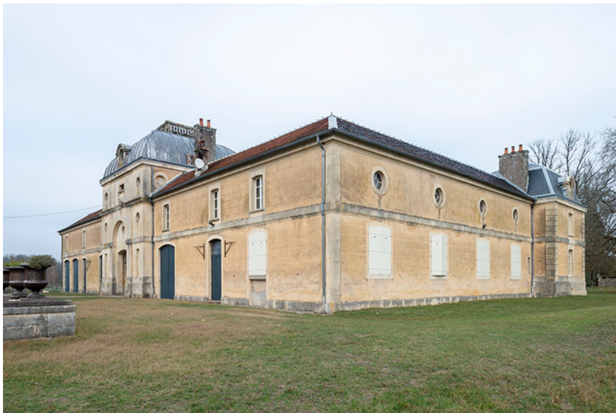
Façade ouest et façade sud de l'écurie.
