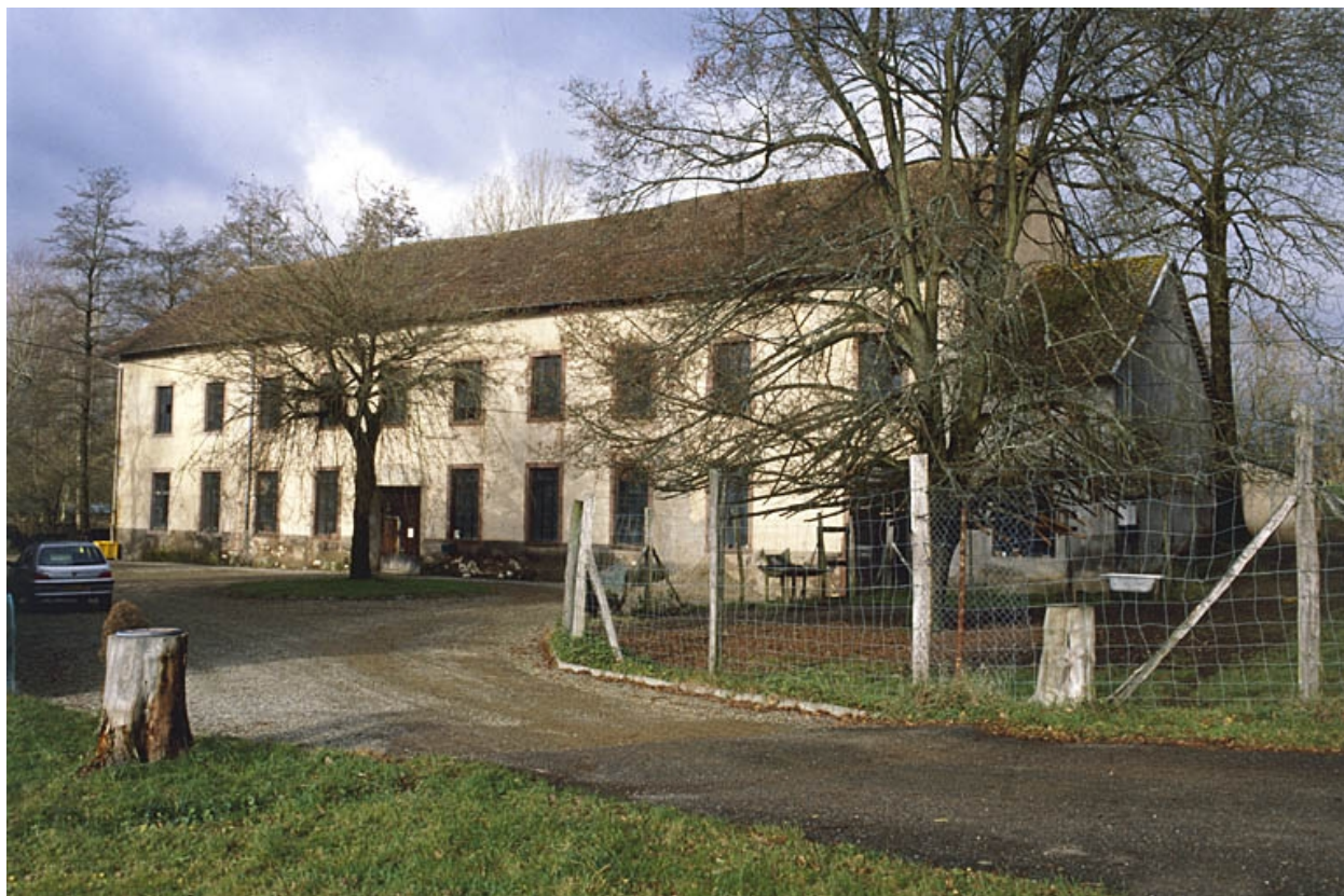
Façade antérieure de l'atelier de fabrication.
