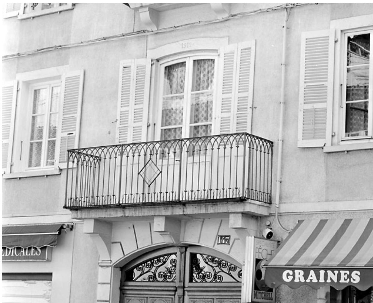
Porte-fenêtre et balcon du premier étage.
