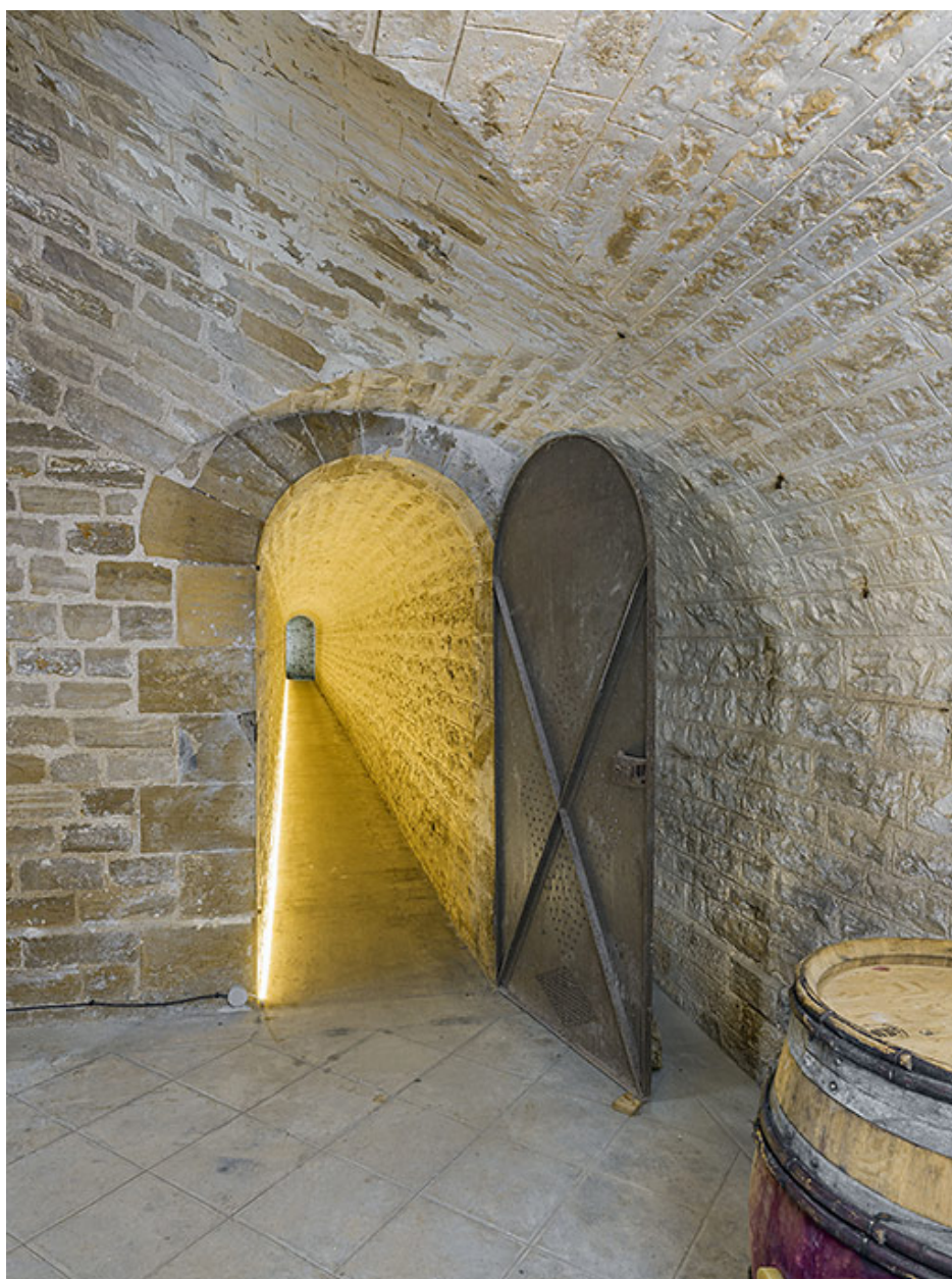
Galerie d'assainissement (droite).
