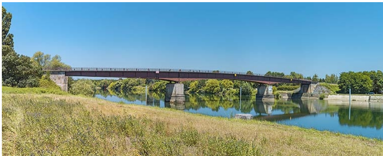
Le pont de Bragny vu d'amont.
