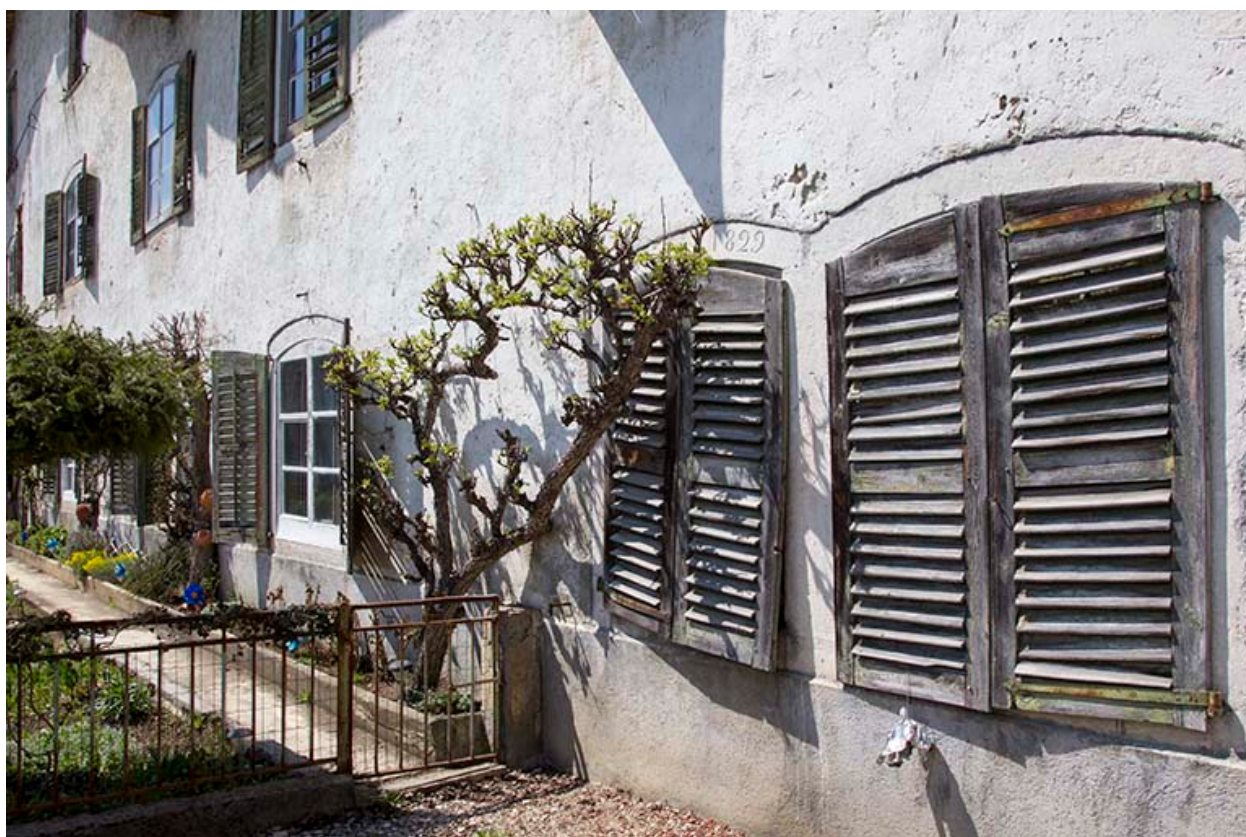
Façade antérieure : fenêtres horlogères à linteau délardé en arc segmentaire.
