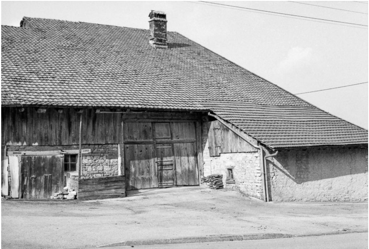
Ferme cadastrée 1962 E 182 : façade latérale droite (?).
