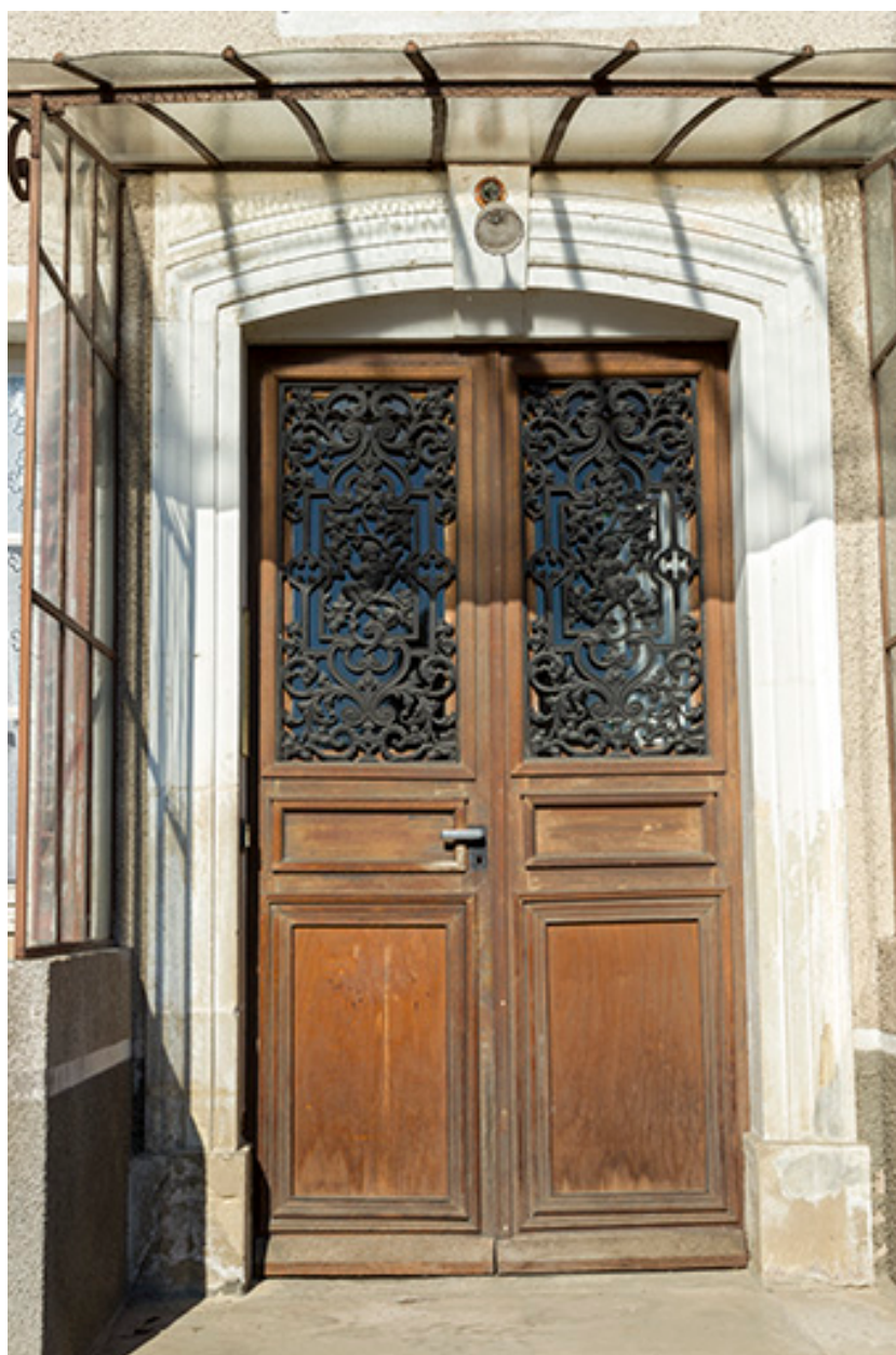
Détail de la porte principale sur rue.
