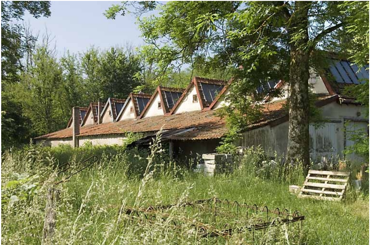
Pignons ouest de l'atelier de fabrication.
