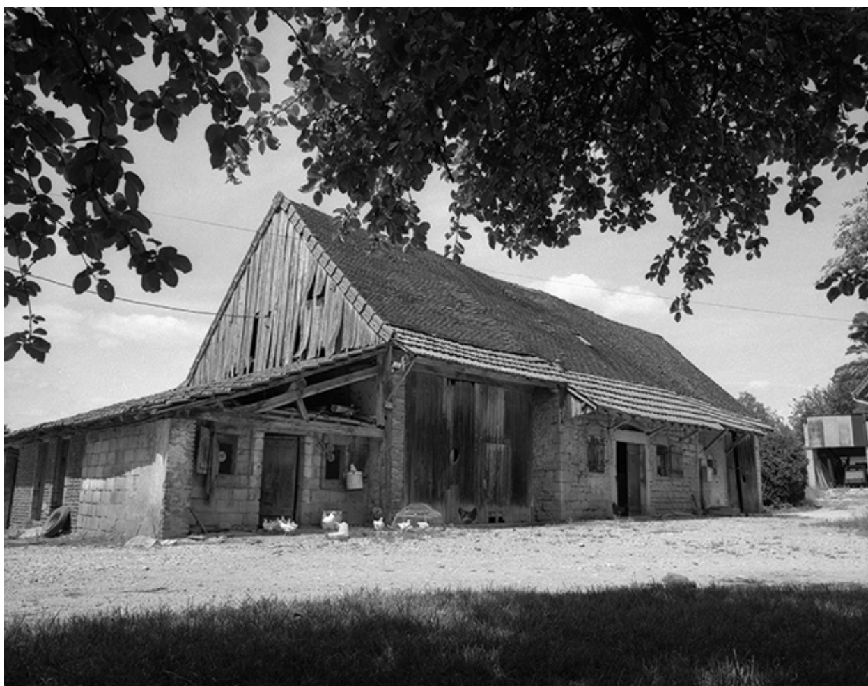
Partie agricole d'une ferme.
