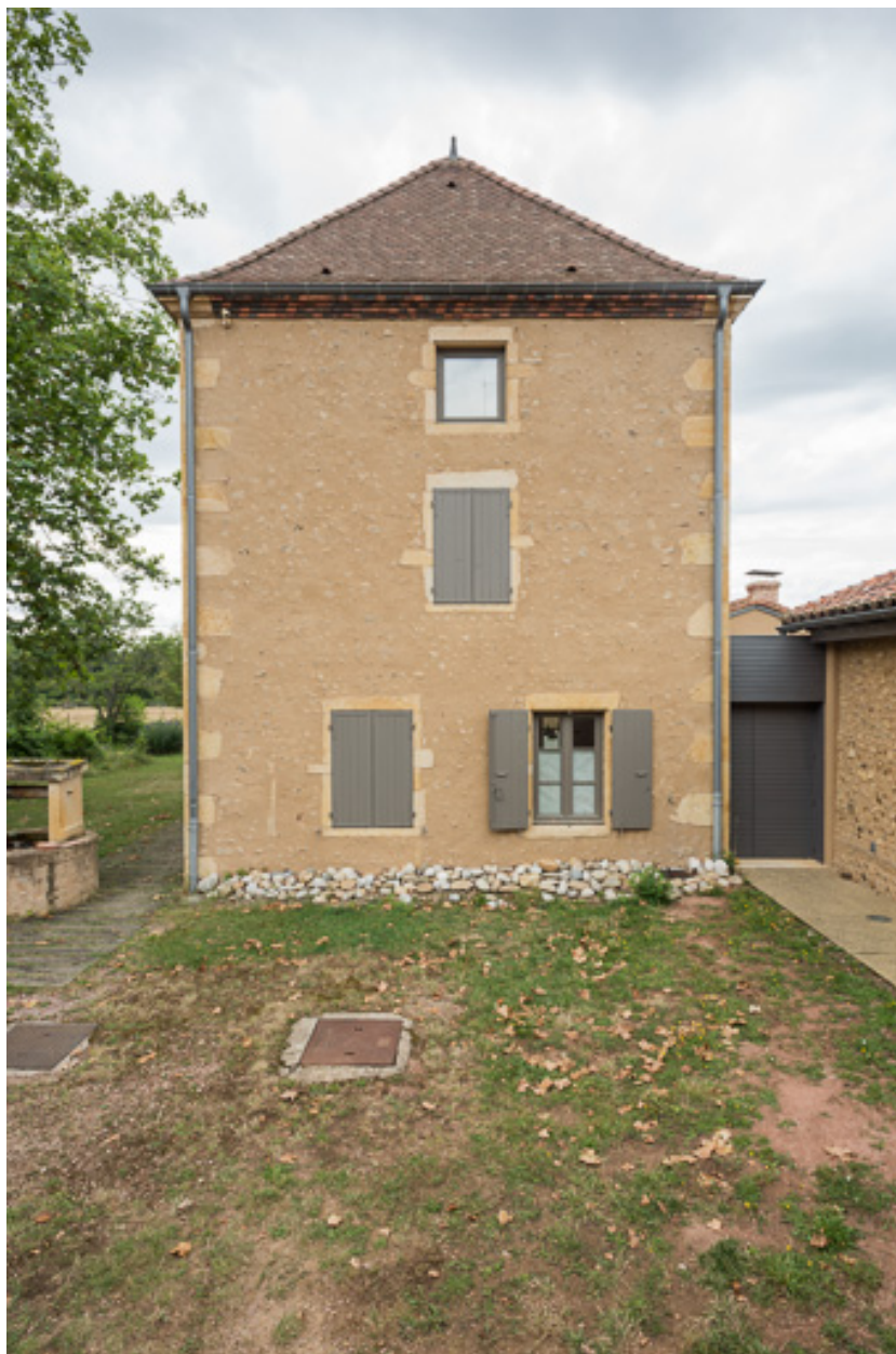
Façade latérale est de la maison
