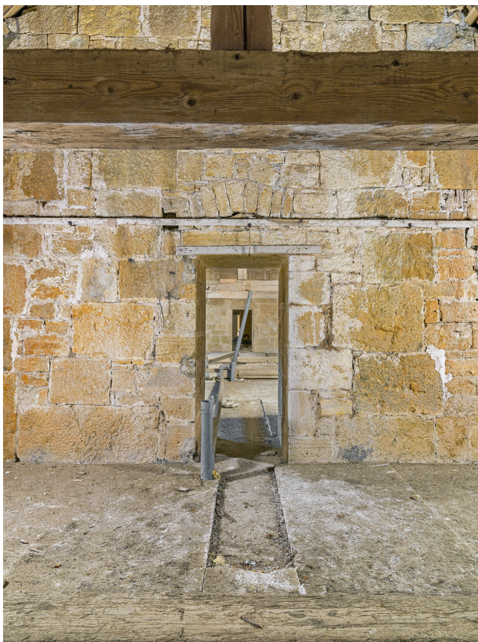
Caserne U, grenier : vue traversante.
