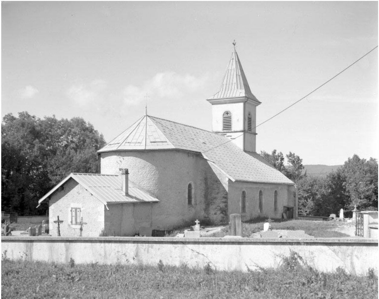
Extérieur : abside et face nord.
