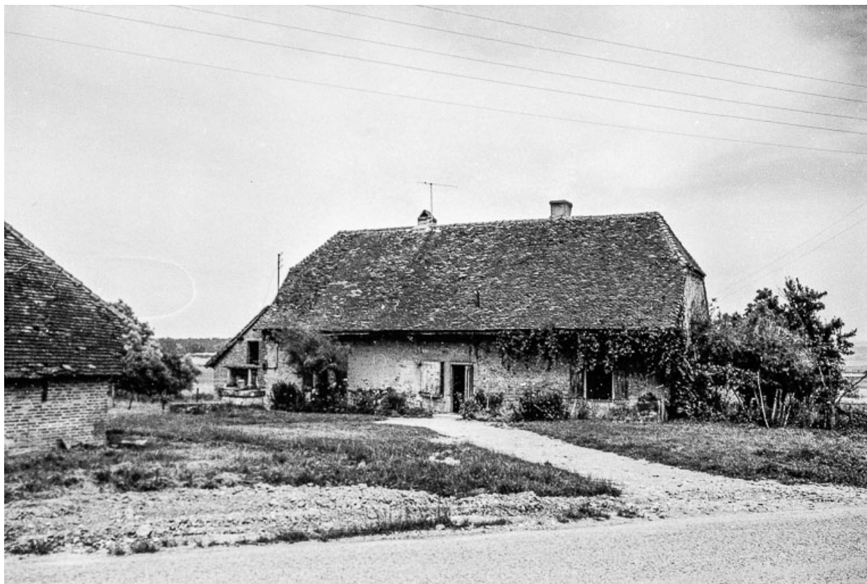
Ferme cadastrée 1963 AC : façade antérieure.
