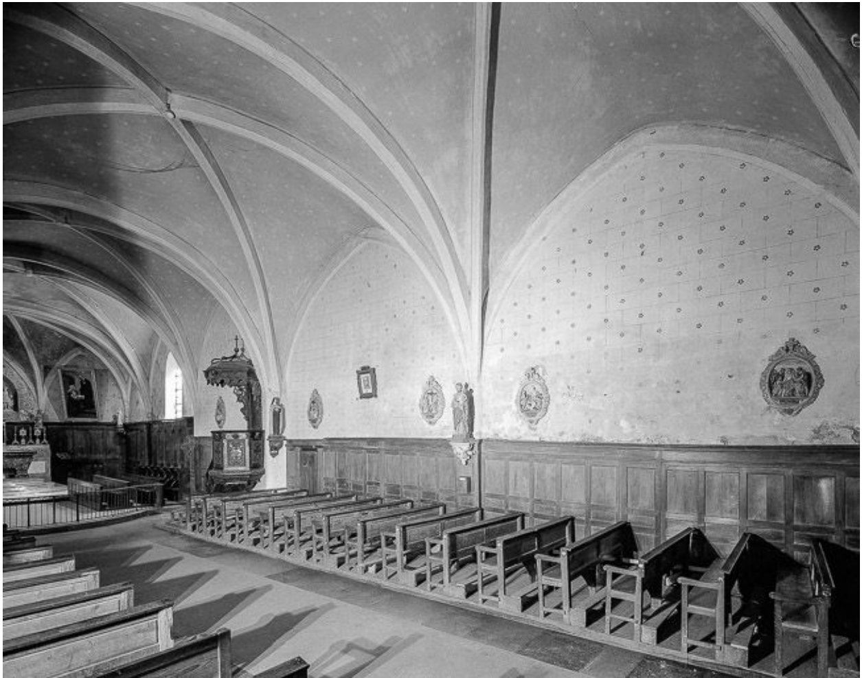
Intérieur : nef, mur droit vu de l'entrée.
