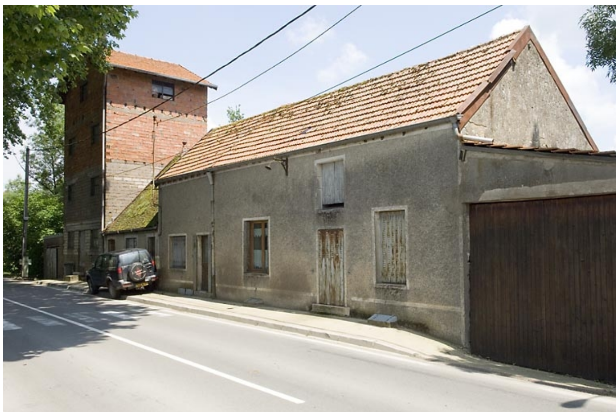
Atelier de fabrication et logement.
