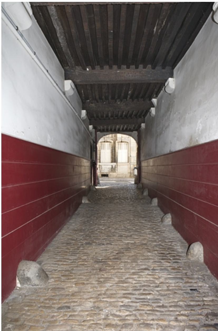
Passage cocher, depuis la cour.
