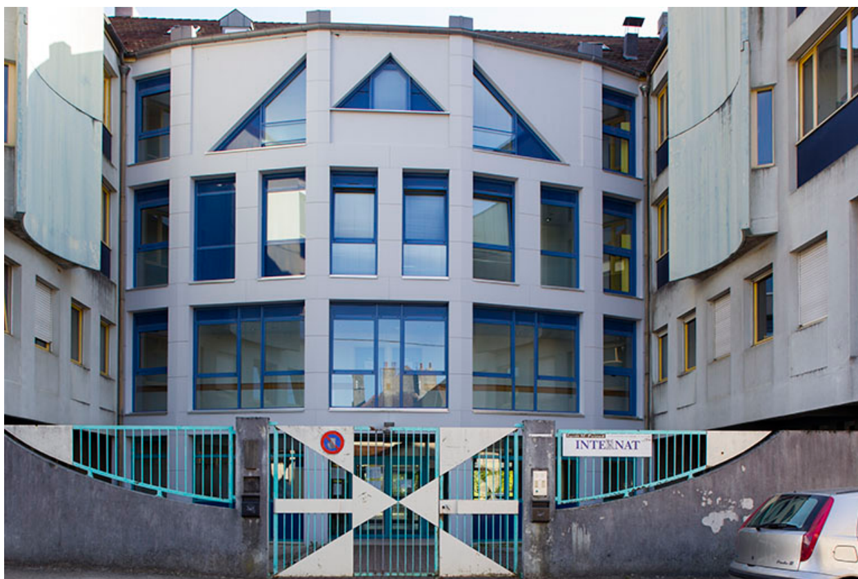
Internat : façade Nord, détail.
