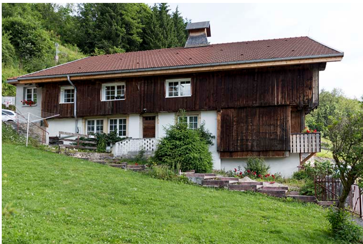
Façade latérale gauche.
