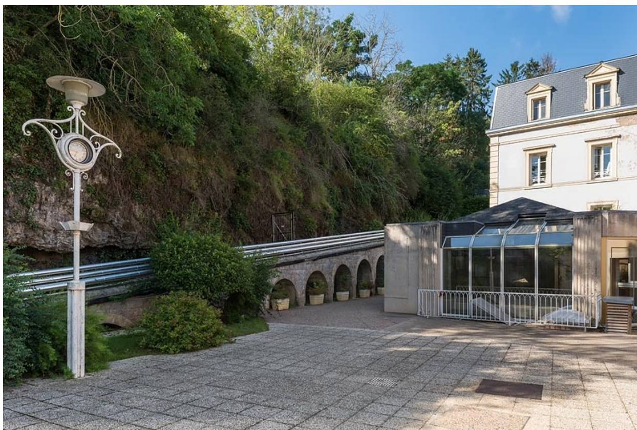
Aqueduc, vue depuis la cour de l'établissement thermal.
