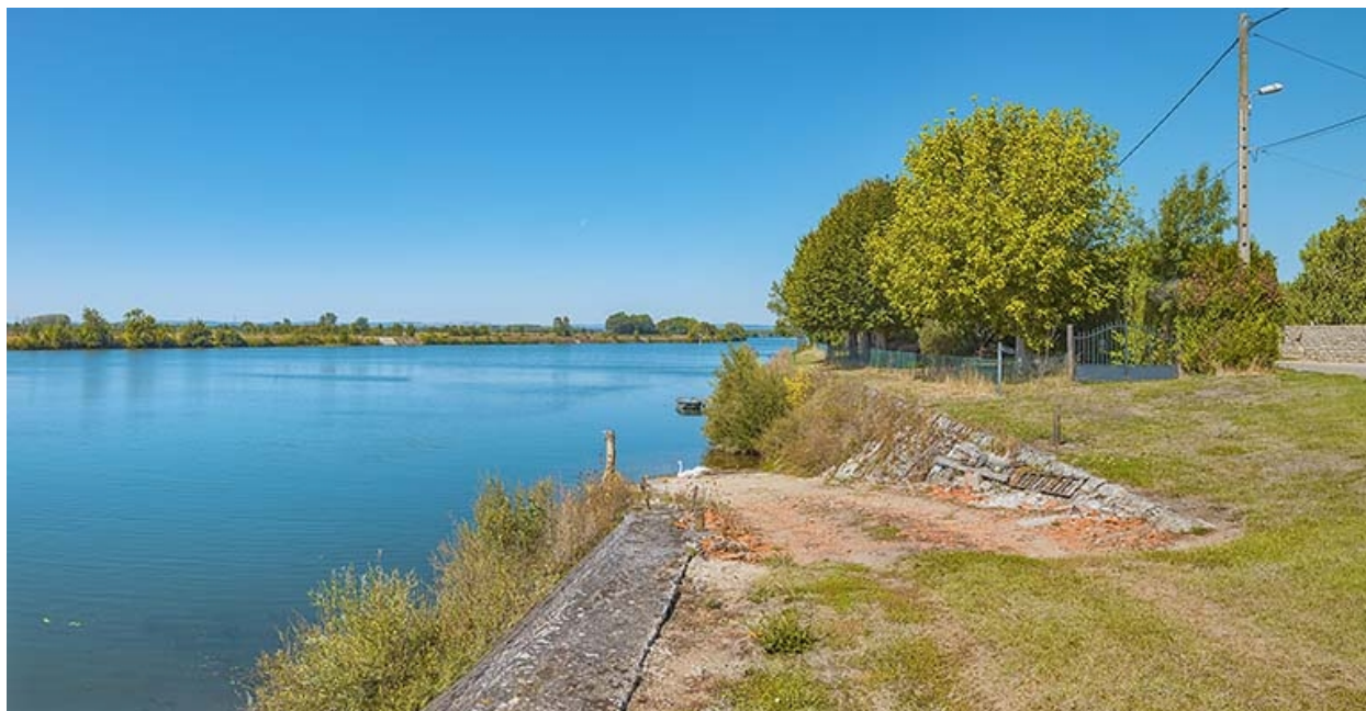
Rampe et perrés au port d'Ouroux.
