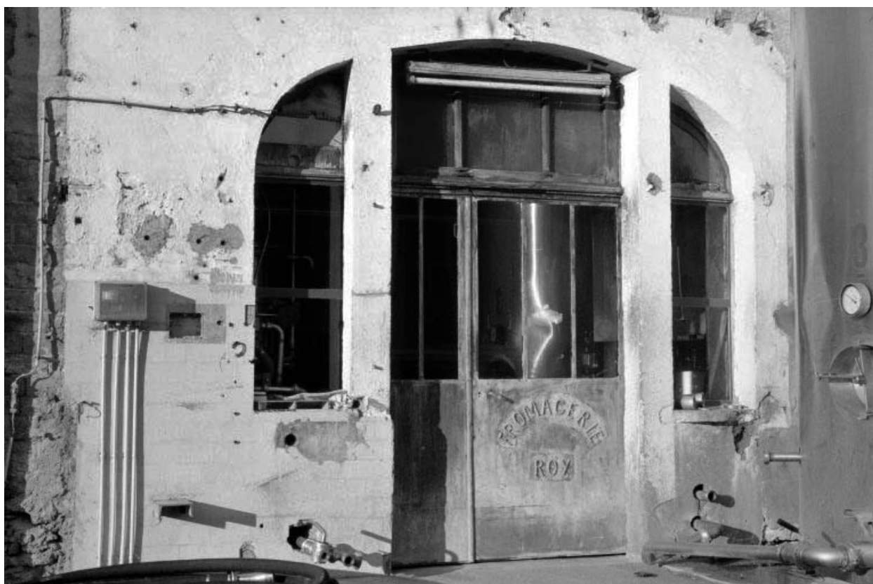
Porte d'entrée de l'atelier de fabrication.
