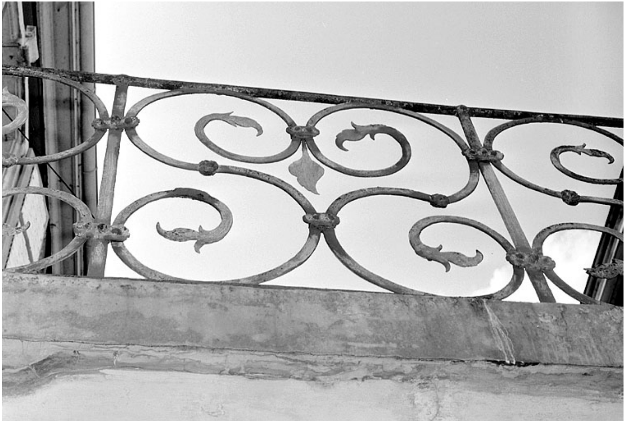
Détail du garde-corps de l'ancienne galerie en terrasse.
