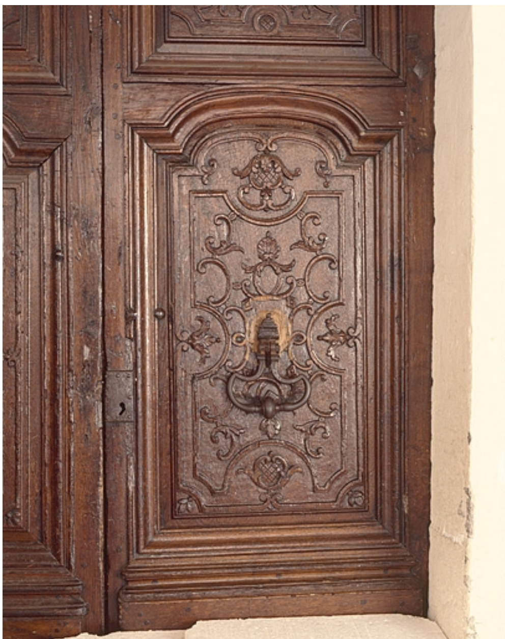
Détail de la porte d'entrée.
