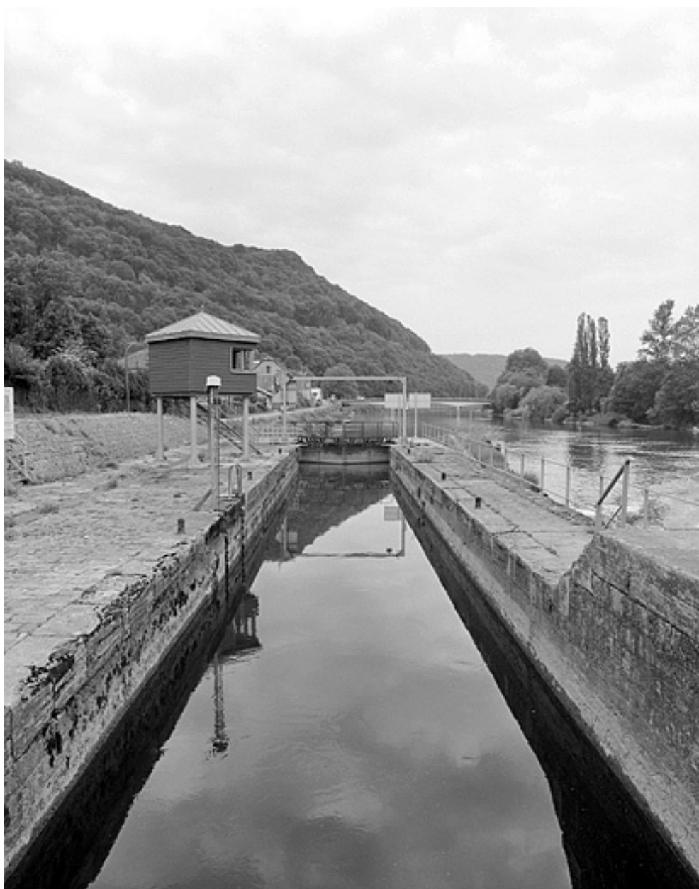
Ecluse et sa porte aval, depuis l'amont.
