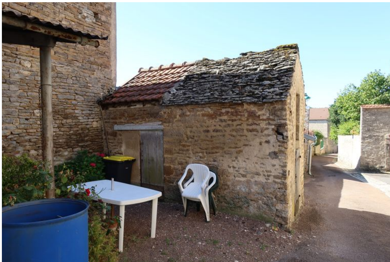
Détail de l'élévation nord de la construction.
