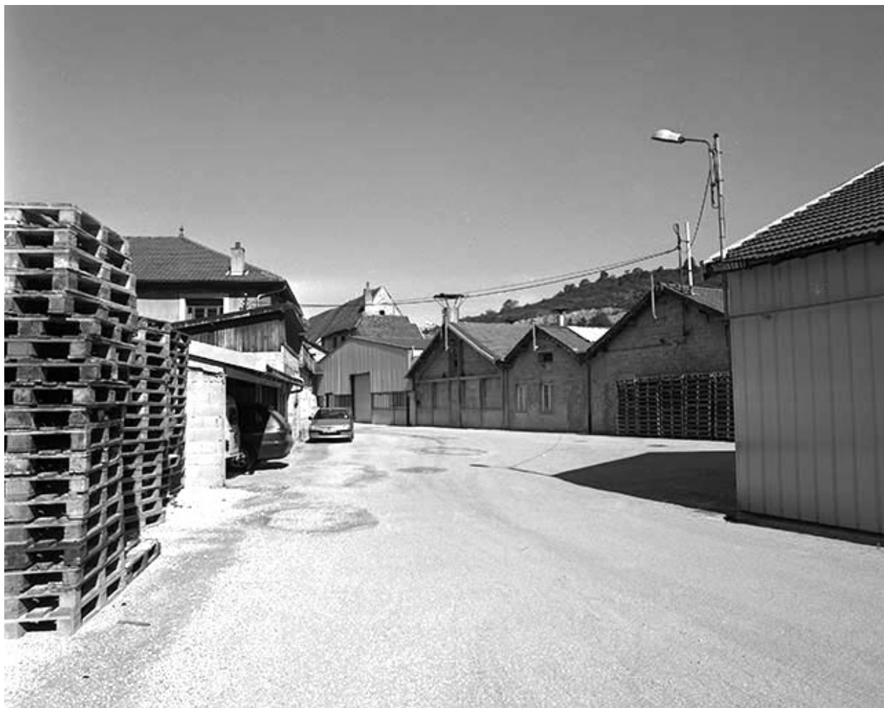
Les ateliers de fabrication depuis la cour.
