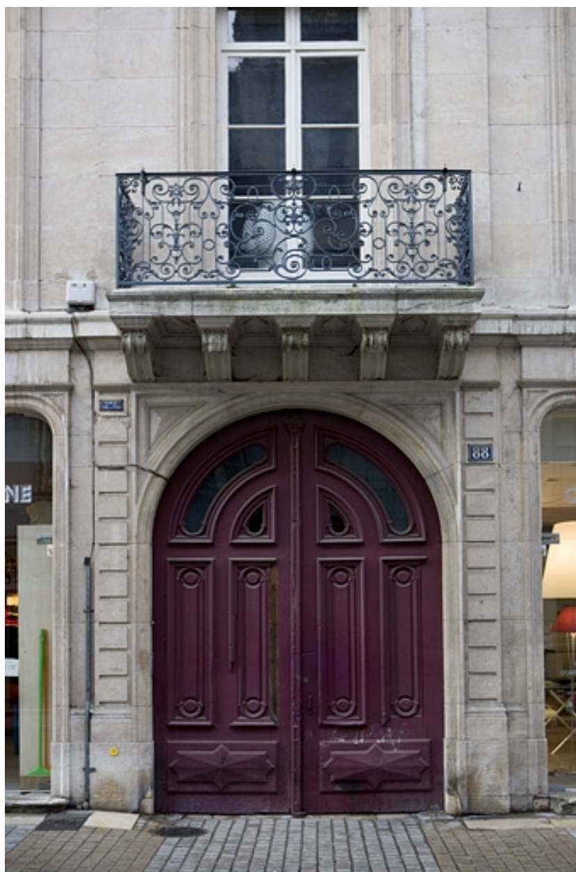
Détail du portail d'entrée, de face.
