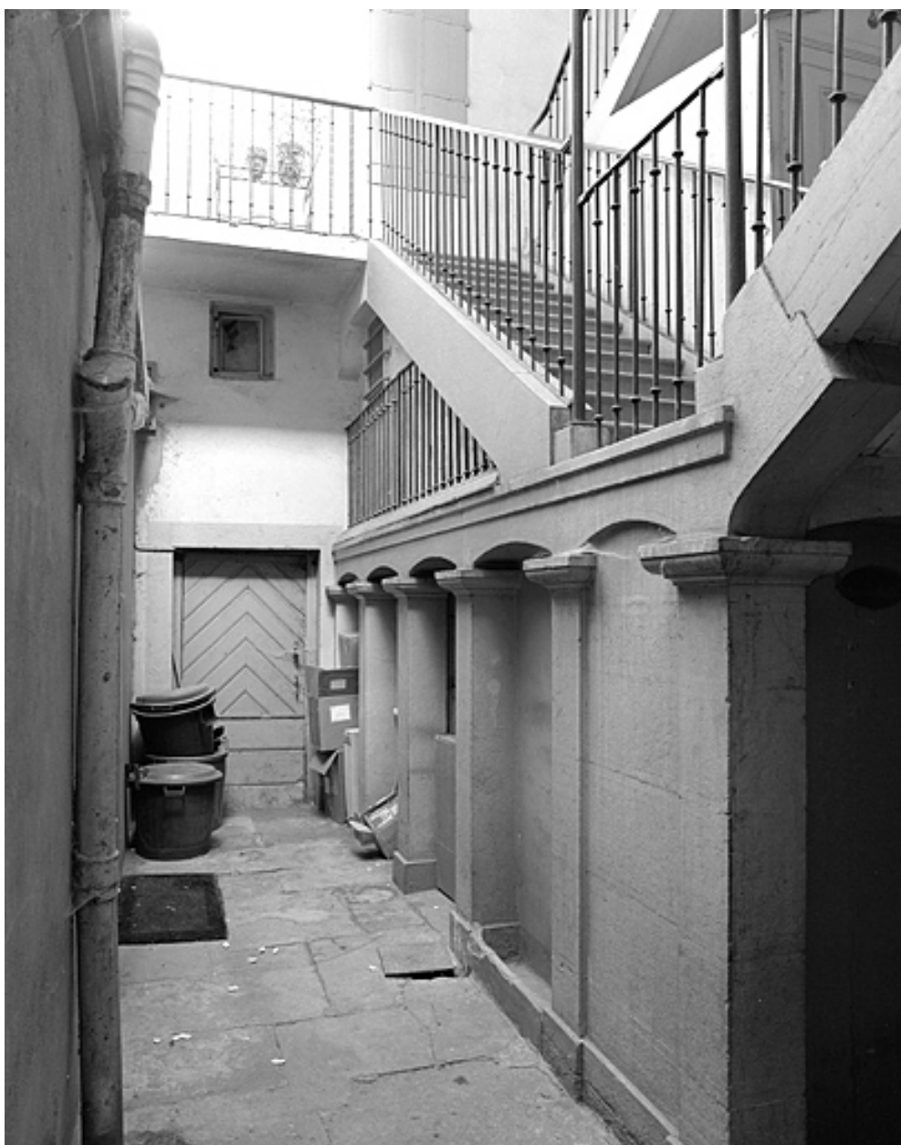
Maison, 58 rue du Commerce, escalier sur cour.
