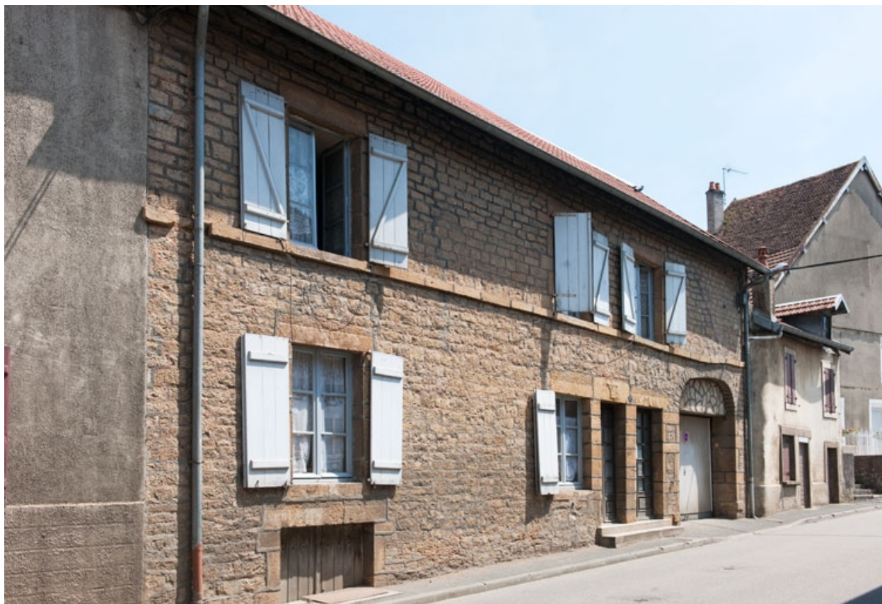
Façade antérieure, vue de trois quart gauche.
