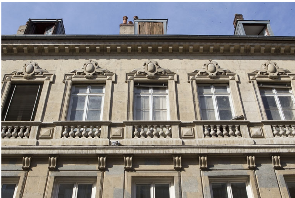
Détail des fenêtres du deuxième étage.
