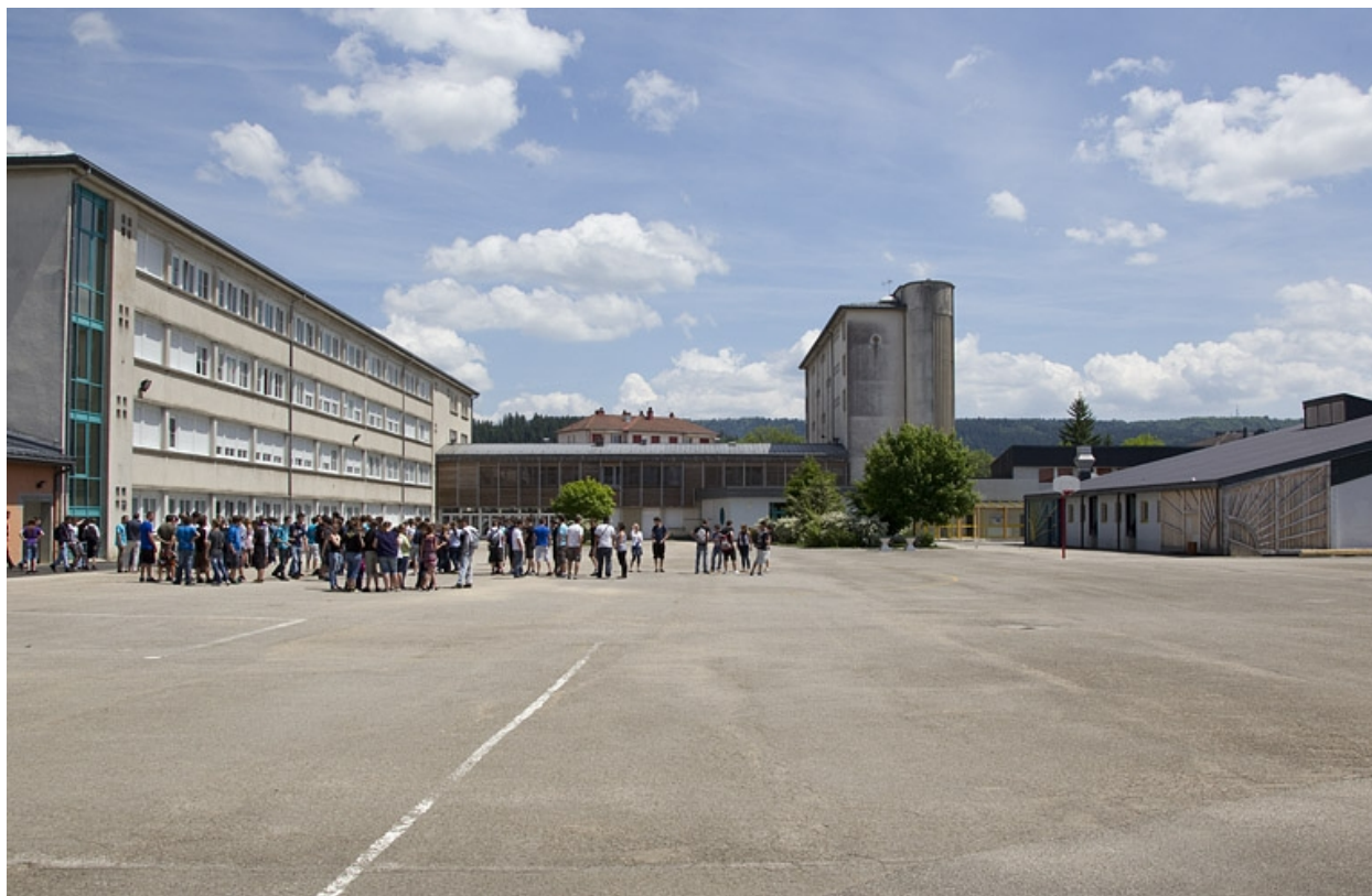
Vue d'ensemble de la cour, depuis l'ouest.
