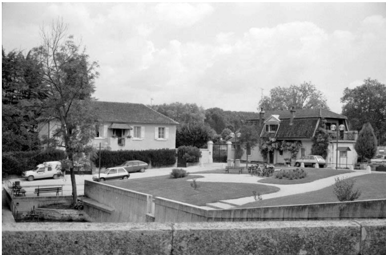
Logement d'ouvriers, vus depuis l'ouest.
