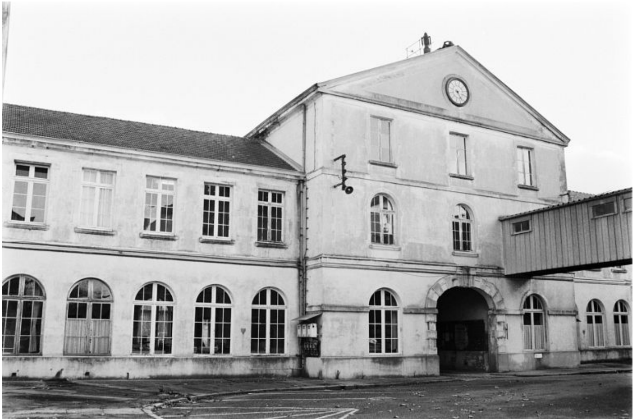
Façade postérieure des ateliers et bureaux centraux.
