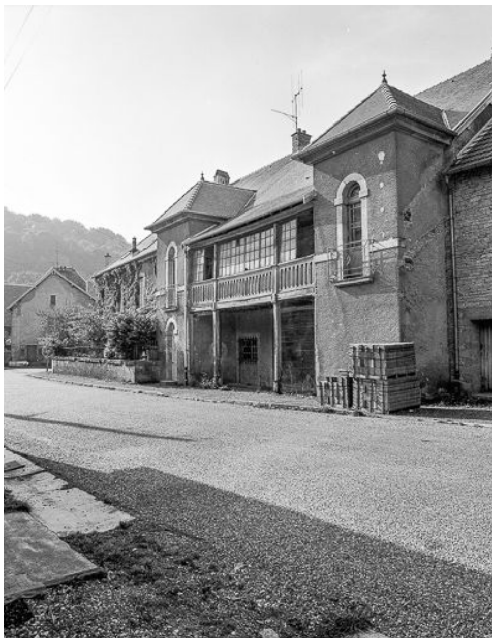
Façade latérale droite.
