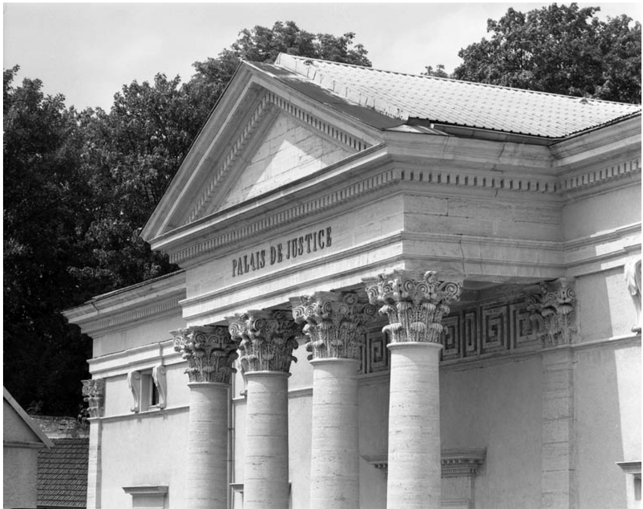
Façade antérieure : avant-corps central, détail du fronton.
