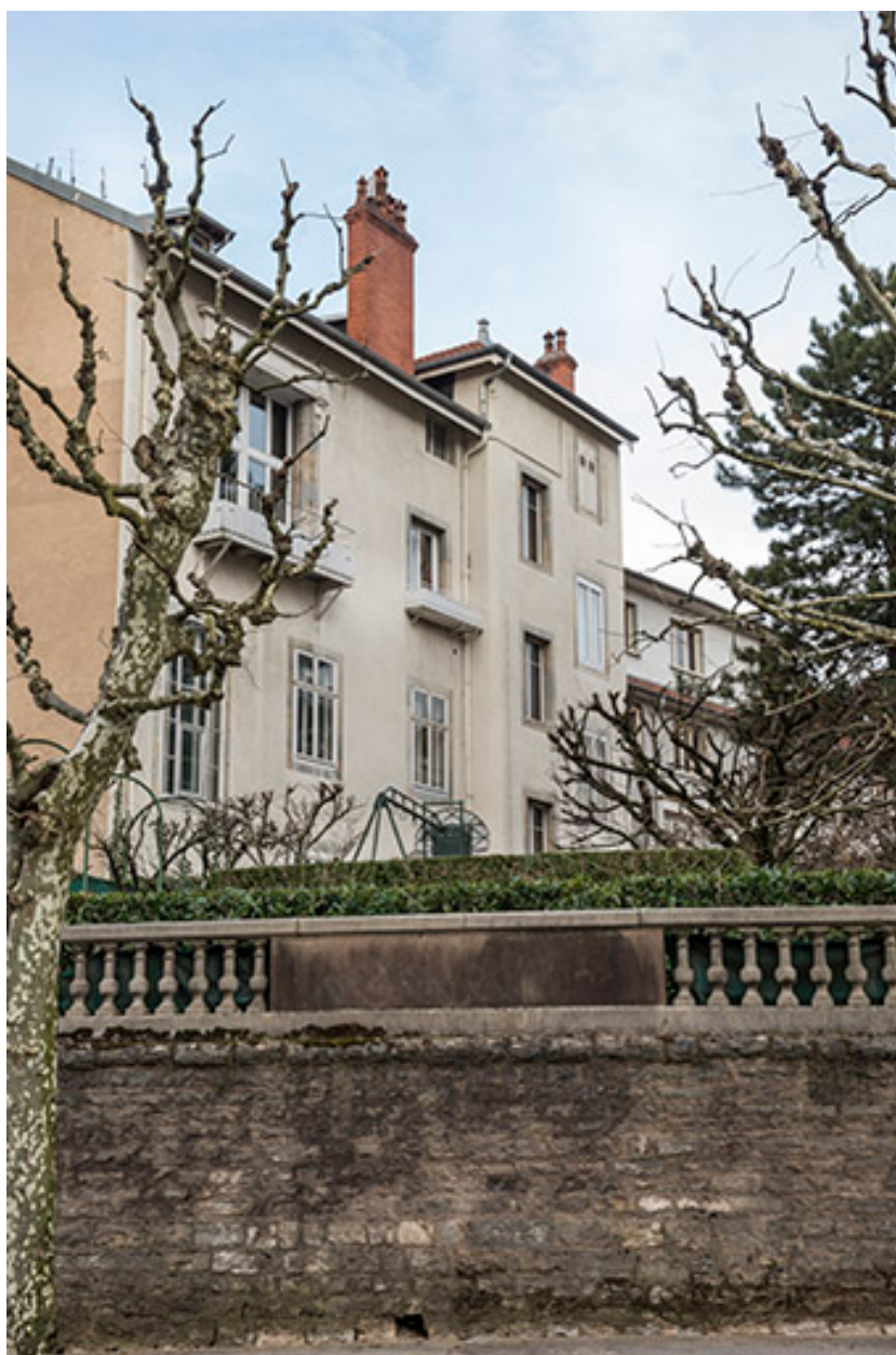
Façade postérieure, depuis l'avenue Denfert-Rochereau.
