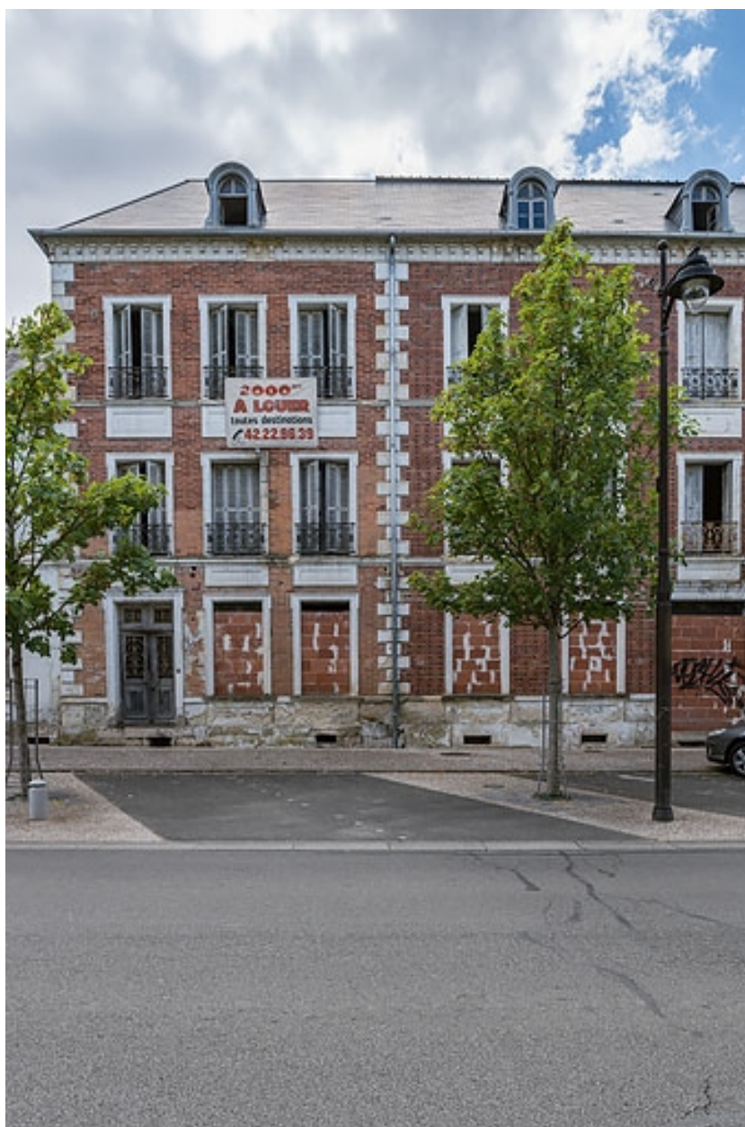
Façade de l'extension de Jules Guimard.
