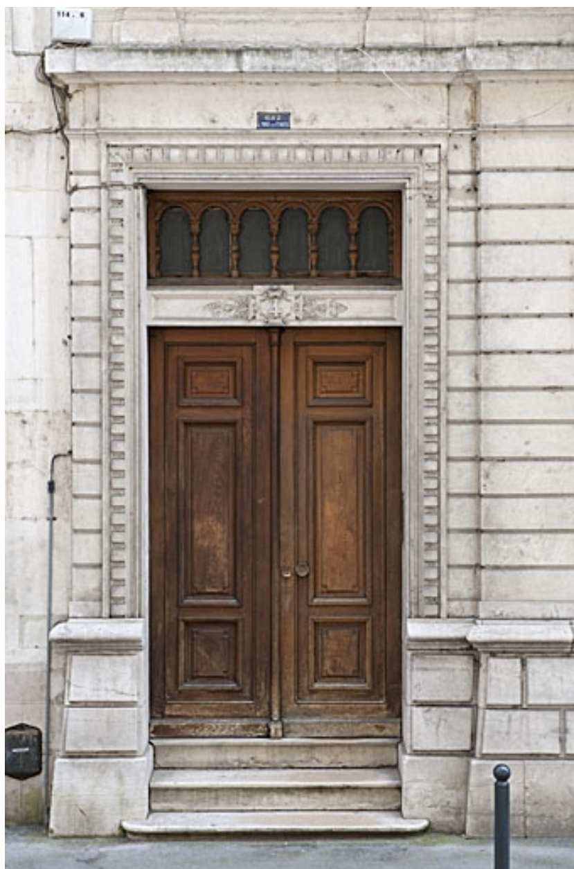
Façade antérieure : détail de la porte d'entrée.
