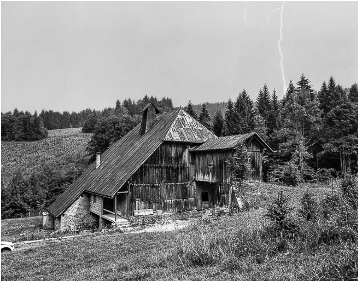
Façade postérieure, de trois quarts gauche, en 1976.
