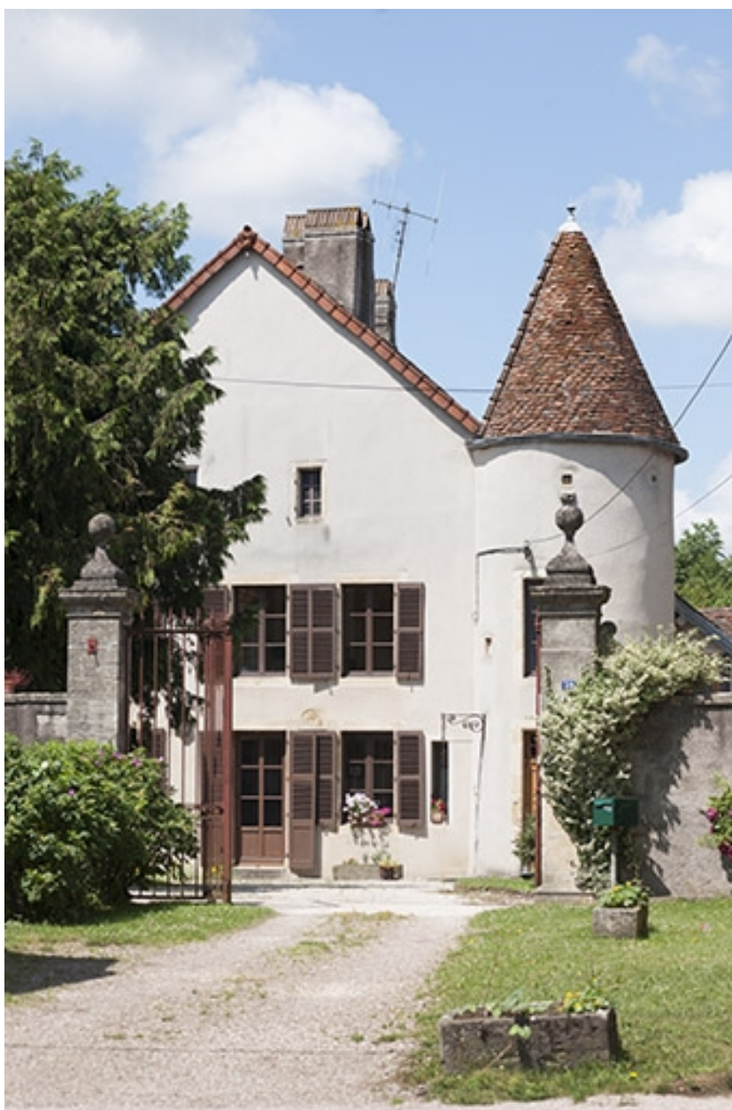
Façade antérieure et tour nord, depuis l'entrée.
