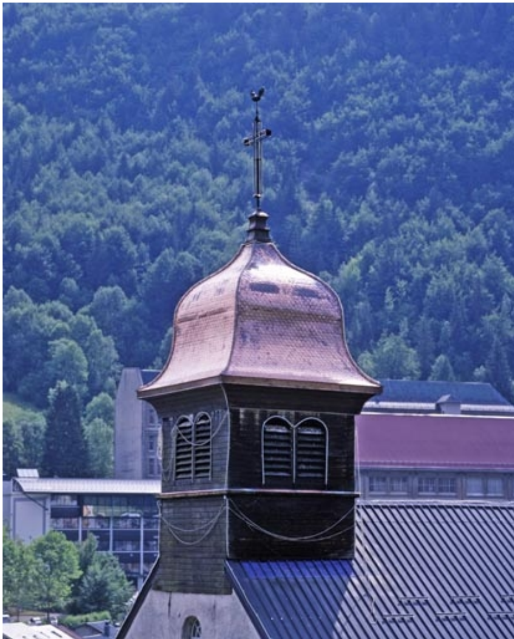
Clocher, depuis le nord-ouest.
