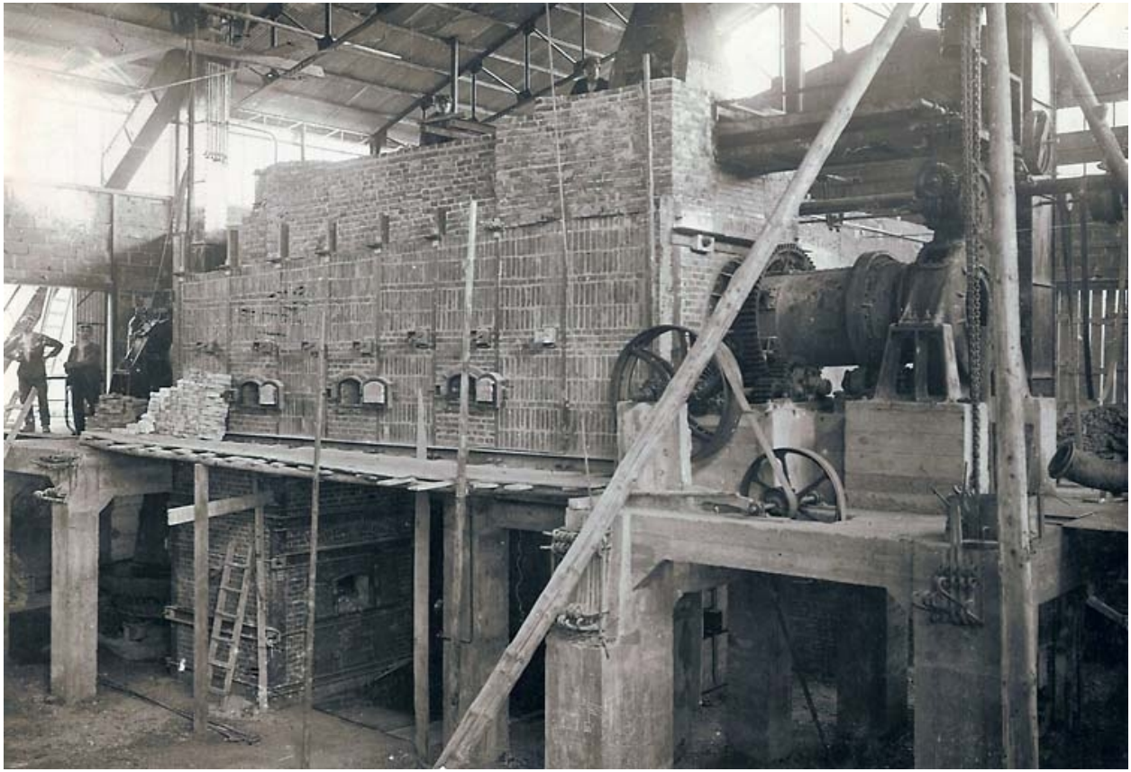
Bâtiment des fours. Four d'essai des schistes.
