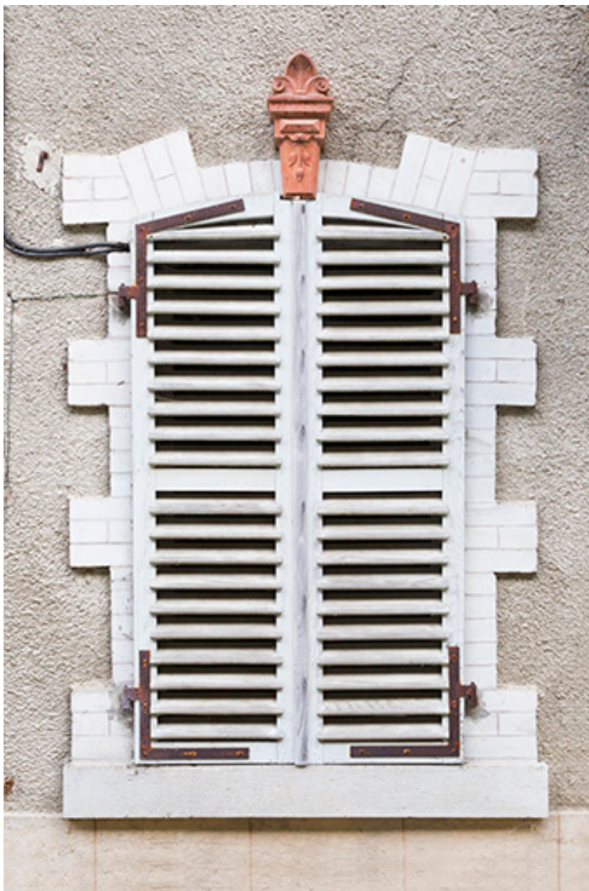
Logement patronal de 1900, façade antérieure : une fenêtre.
