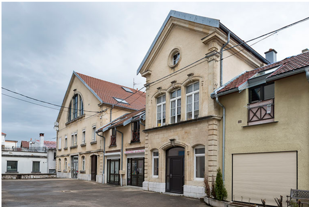
Façade des chais et entrepôts. Vue partielle.
