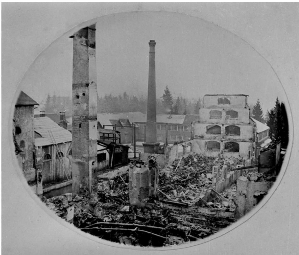
L'usine des Fonteneilles après l'incendie du 23 janvier 1881.
