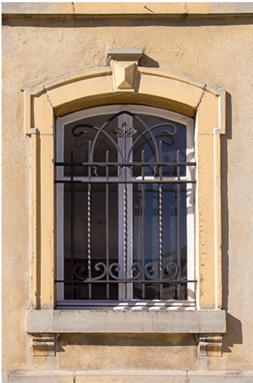
Fenêtre du corps de bâtiment occidental.
